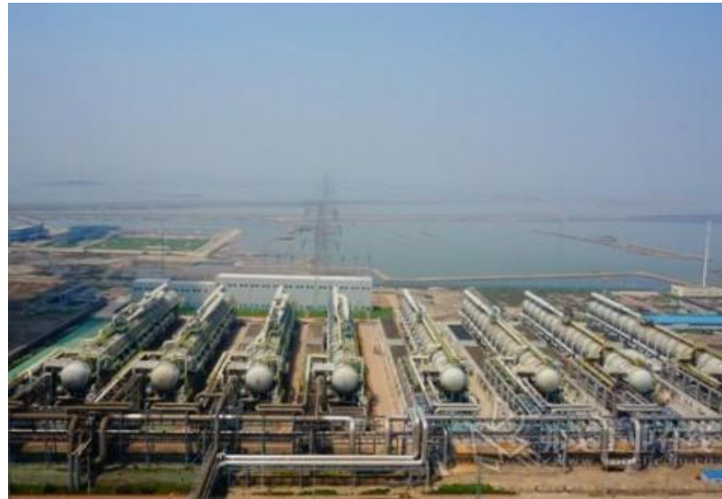
海水淡化厂全景图
